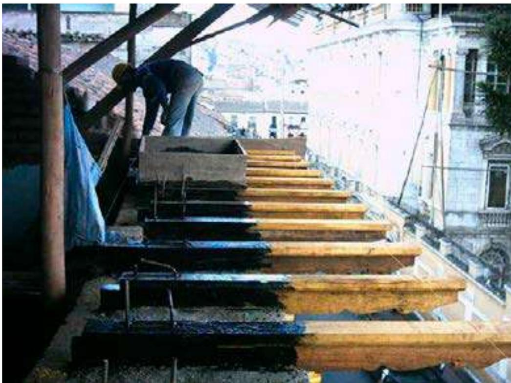
Foto 74. Amarrado de carrizo entre vigas de cubierta. Foto M. Hidrobo, 2003
