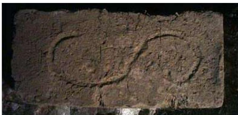
El deterioro que presentaban varios muros de adobe, obligó a que muchos sean desmontados por partes, y algunos en su totalidad. Se rehicieron los adobes con una mezcla bastarda<sup>14</sup>: la misma tierra reciclada, con la adición de productos disponibles como la resina, el cemento, cal y fibra mineral, como reemplazo de la paja y los materiales ligantes de origen animal, que se usaban tradicionalmente. (Ver Anexos, Fotos 41, 42 y 43).
