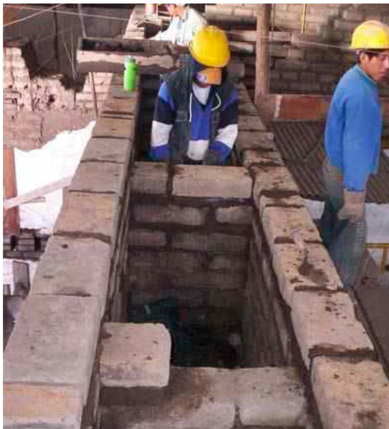
Foto 48. Muros que fueron levantados en su totalidad y muros rematados con adobe nuevo. Foto M. Hidrobo, 2005
