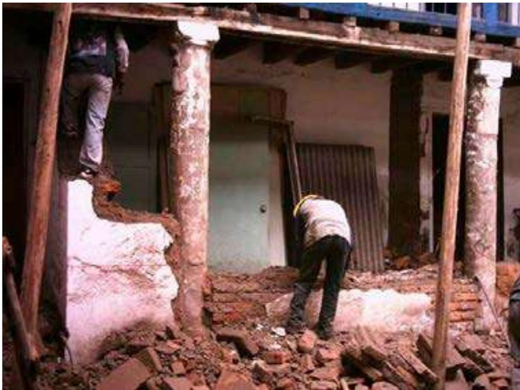
Foto 30. Columna de piedra recuperada en galería de patio 1. Foto M. Hidrobo, 2005
