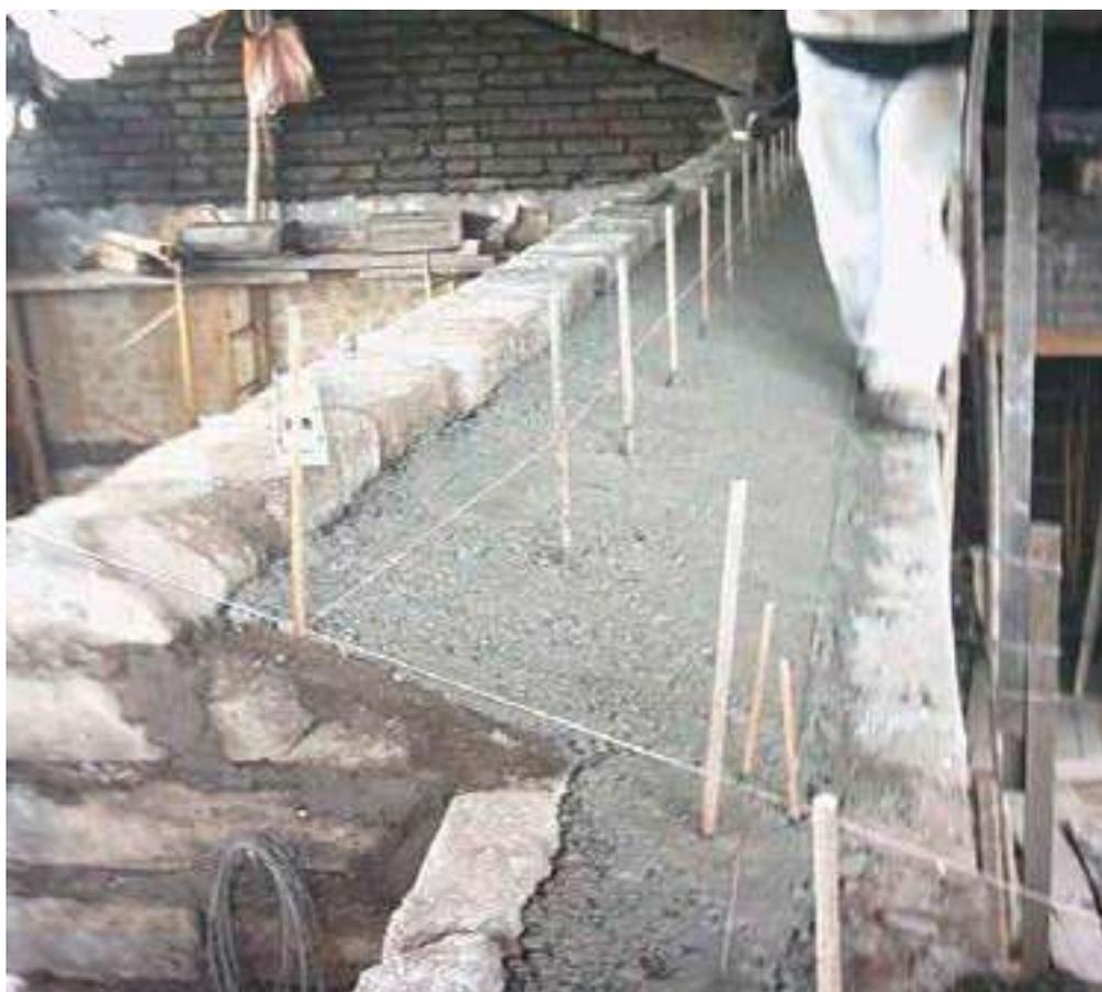
Foto 57. Cabeza de muro fundida con chicotes y vigas de estructura de cubierta. Foto M. Hidrobo, 2005
