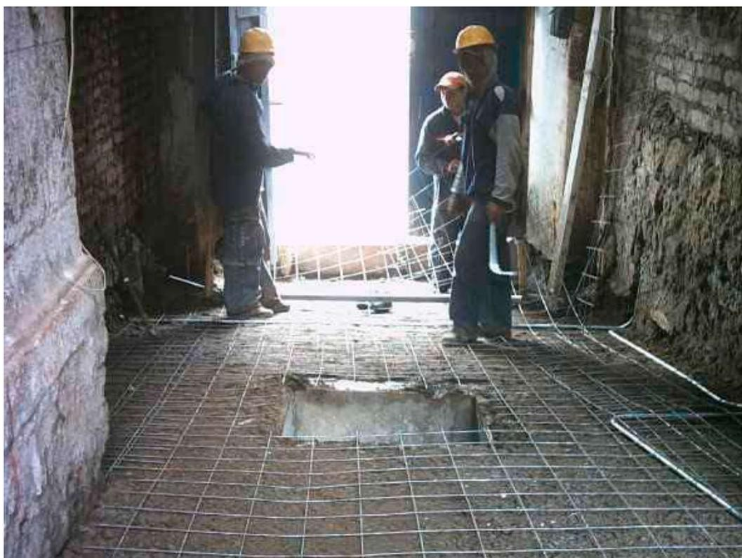
Foto 36. Preparación para fundir el contrapiso en galerías. Vista de muros pelados: piedra de base y calzados con variedad de materiales. Foto M. Hidrobo, 2005.
