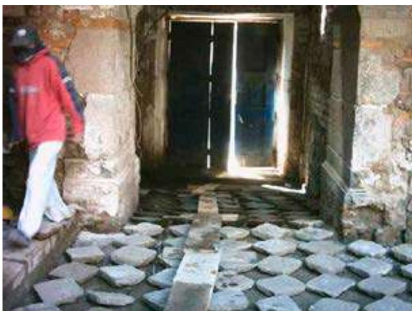
Foto 39. Pisos de piedra bola en galerías. Foto M. Hidrobo, 2005.
