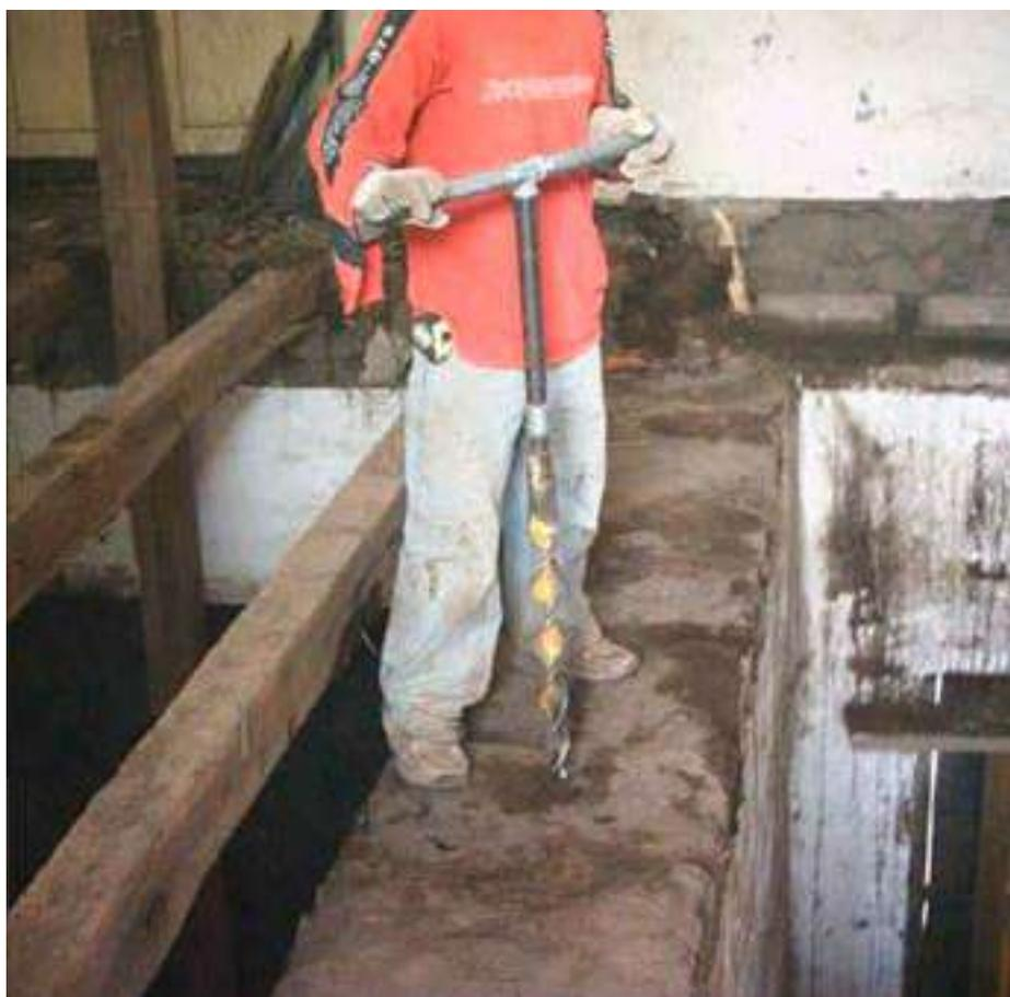
Foto 59. Perforación manual con barrenos para colocar micropilotes horizontales. Foto M. Hidrobo, 2005
