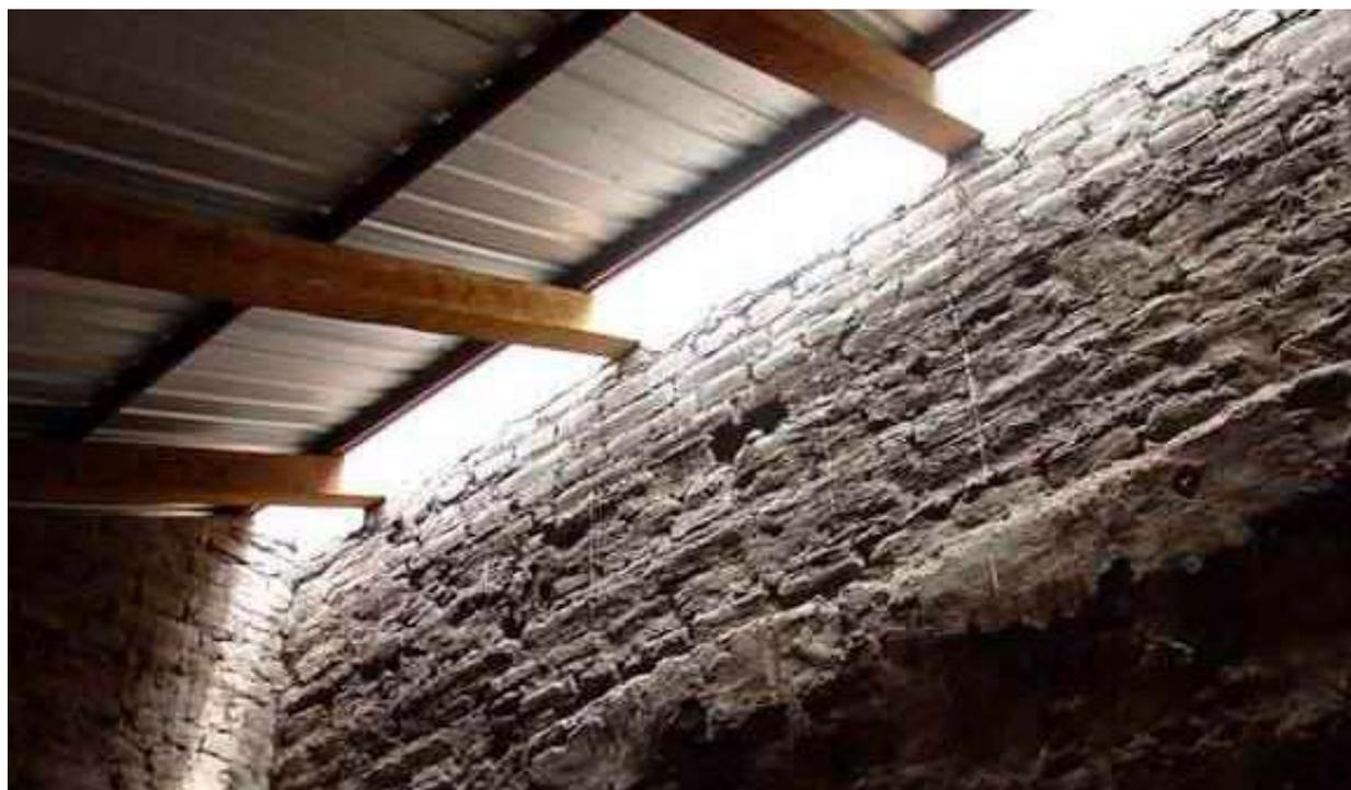
Foto 83. Vista de cerchas de par y nudillo y detalle de claraboya en cumbrero de cubiertas. Foto M. Hidrobo, 2006
