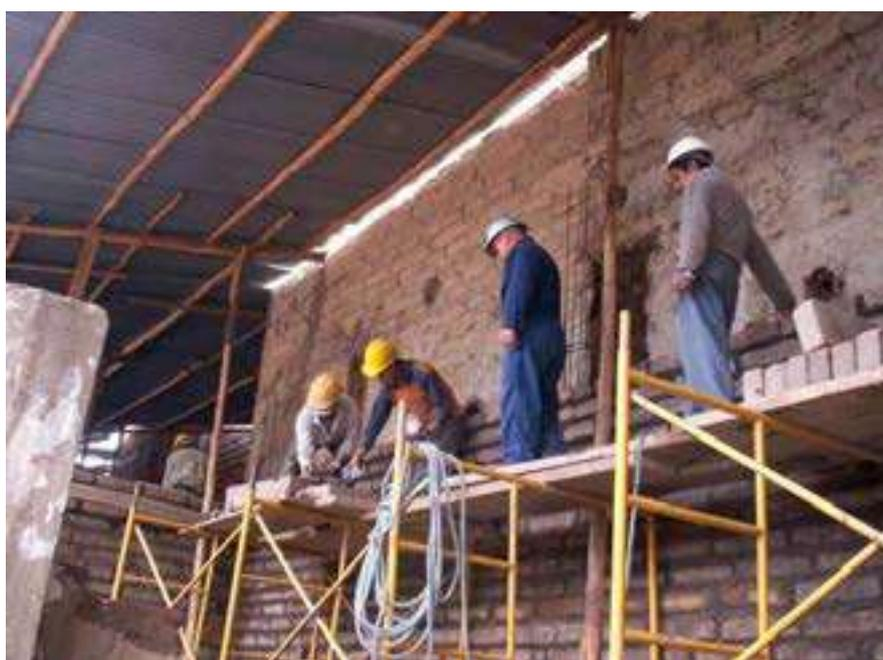
Foto 61. Refuerzos de hormigón y hierro en muros de adobe. Foto M. Hidrobo, 2005
