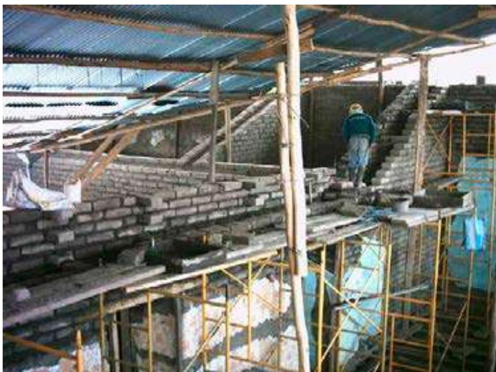
Foto 49. Retirado de enlucidos en muros de adobe y arquería de ladrillo. Foto M. Hidrobo, 2005
