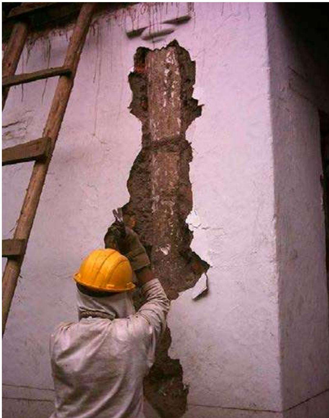
Foto 29. Liberación de mamposterías que escondían algunas columnas de la galería del patio 1. Foto M. Hidrobo, 2005
