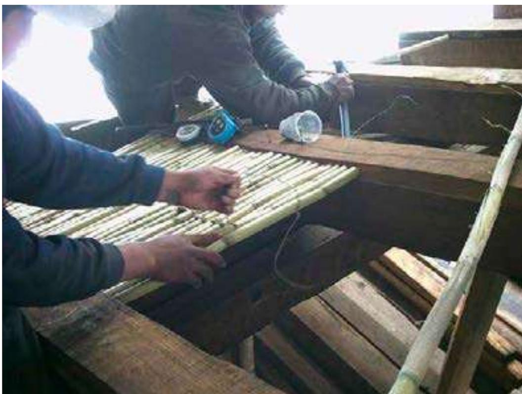
Foto 75. Vista de entresijos recuperados: pilares de piedra, estructura de madera, pilares, pasamanos, cielo raso de carrizo y moldura de cemento en galerías, patio 1.
