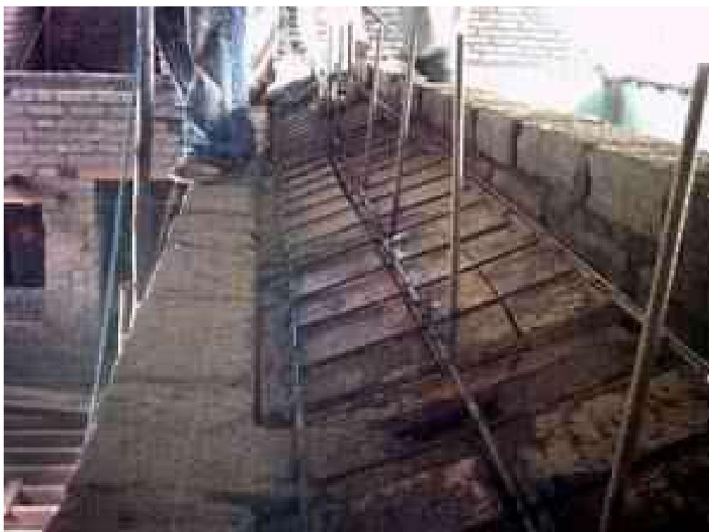
Foto 56. Cabeza de muro fundida con chicotes para recibir piezas de cubierta. Foto M. Hidrobo, 2005
